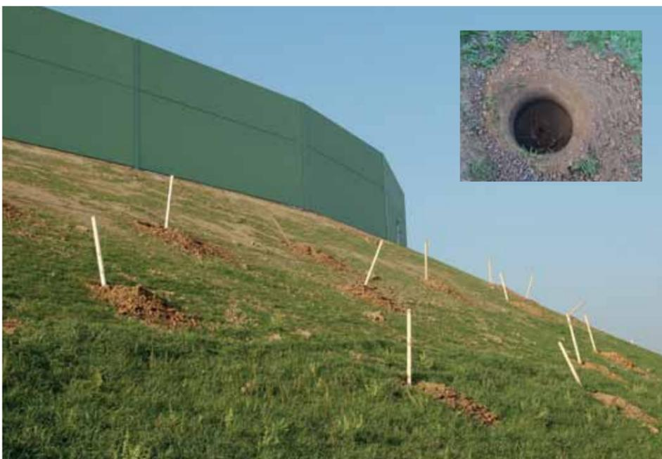
13 Meter hohe Böschung mit 40 Grad Gefälle: Baum-Pflanzlöcher werden maschinell gebohrt.
