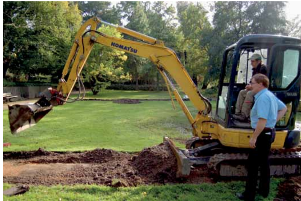
Die schweren Baumaschinen wurden für den Einsatz in Naturschutzgebieten umgerüstet. Projektleiter Herr Böhler überwacht die Fortschritte vor Ort.
