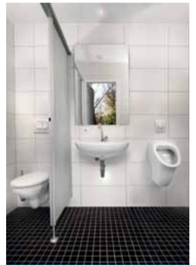
Toilettenanlagen für Damen und Herren wurden in das Modul integriert.
