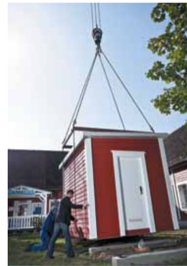
Die Montage und das Anschließen dauerte wie geplant keine zwei Stunden.
