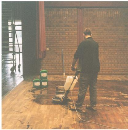
Vorbereitung des Holzfußboden mit einer Einscheibenmaschinen
