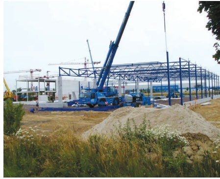
Fertigmodule werden auf der Baustelle zusammengeführt
