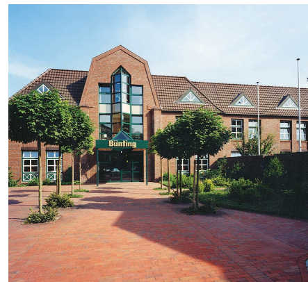
Ein modernes Verwaltungsgebäude sorgt für einen reibungslosen Ablauf
