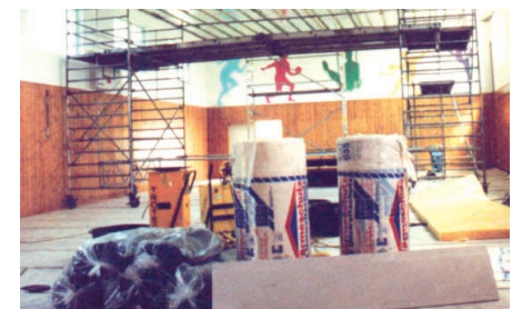
Sanierung einer Turnhalle
