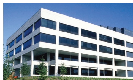
PPP ermöglicht die Realisierung von öffentlichen Neubauten
