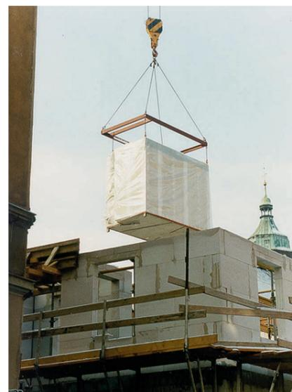
Montage einer Fertignaßzelle
