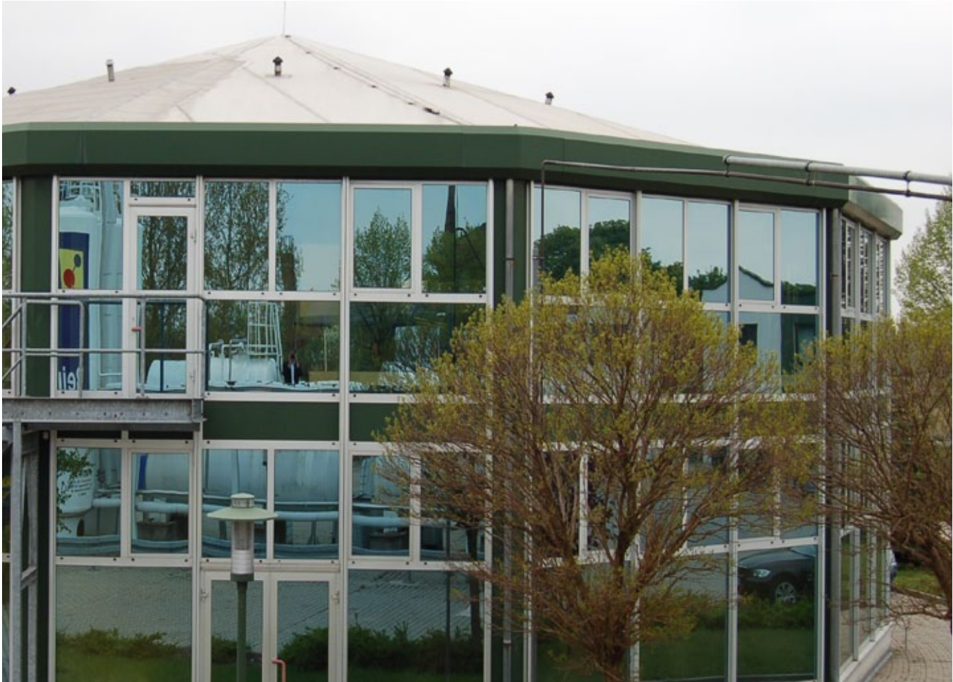
Produktionsbetrieb und Schulungszentrum der Richard Kühn GmbH Chemische Fabrik in Illerstedt, Sachsen-Anhalt
